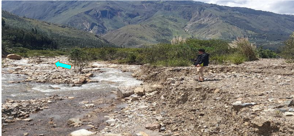
FIGURA N°01: TRAMO CRÍTICO EN EL RIO LORICHUCO EN EL SECTOR YANASARA SE APRECIA AGUAS ABAJO LA NECESIDAD DE ENROCADO EN AMBAS MARGENES DEL RIO
