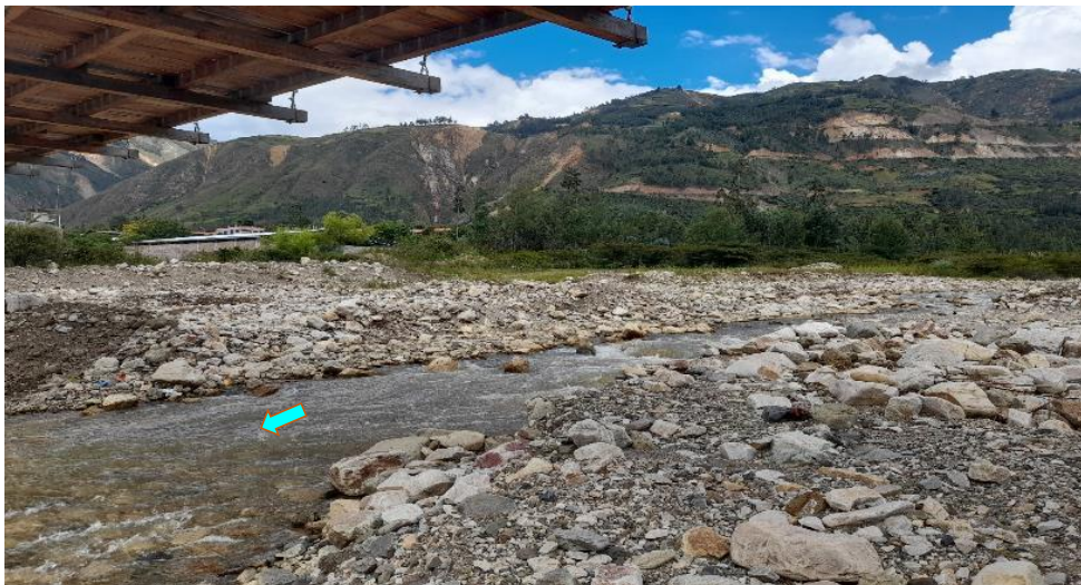
FIGURA N°03: SE OBSERVA AMBAS MARGENES DEL TRAMO DEL SECTOR YANASARA DEL RIO LORICHUCO EN EPOCA DE AVENIDAS EROSIONA LOS TALUDES NECESITANDO DE UNA PROTECCION PERMANENTE EN DEFENSA DE LAS VIVIENDAS ALEDAÑAS T TERRENOS DE CULTIVO
